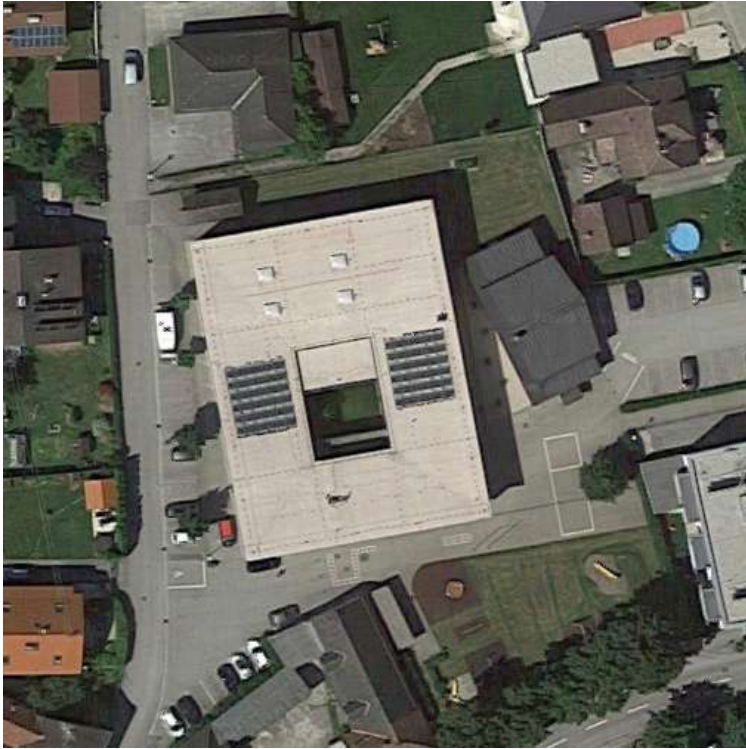
60 Solarmodule á 255Wp auf der Volksschule
